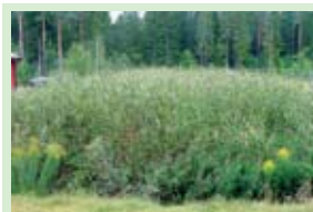
2001 Водочистная станция, Швеция 1.700 m 2 Тростниковый фильтр
